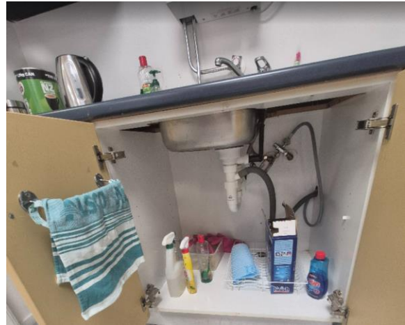
E14 – no equipotential bonding
