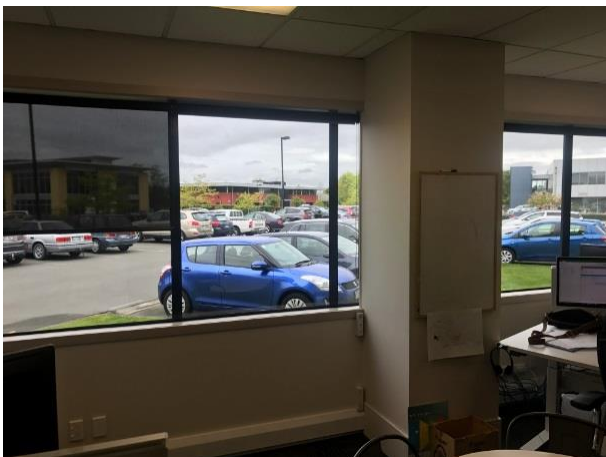
B2- Perimeter columns
